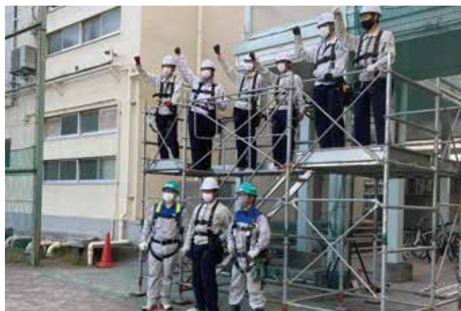
足場が完成して全員でガッポーズ!
