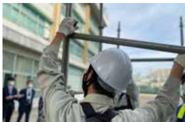
布材の取付け
