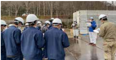
国道5号共和町島付内川3号橋A1橋台工事
