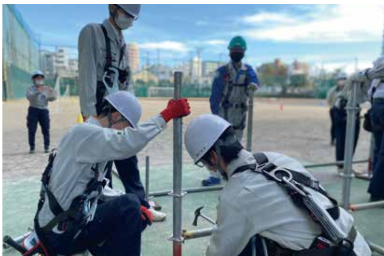
支柱の取付け
